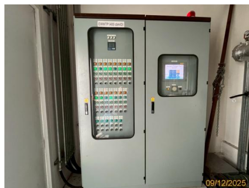
รูปที่ 2-24 ตู้ควบคุมระบบบำบัดน้ำเสีย และมิเตอร์ไฟฟ้า สำหรับระบบบำบัดน้ำเสียโดยเฉพาะ
