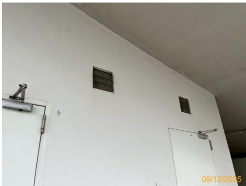
รูปที่ 2-48 พัดลมดูดอากาศภายในห้องพักขยะรวม
