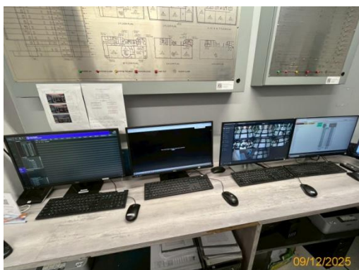
รูปที่ 2-41 ระบบควบคุมแสงสว่างภายในโครงการ
