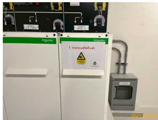
รูปที่ 2-36 ติดป้ายเตือนอันตรายจากไฟฟ้าแรงสูง
