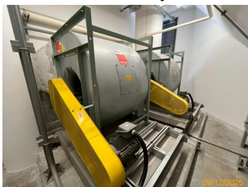
รูปที่ 2-44 จัดให้มีการติดตั้งระบบระบายอากาศ
